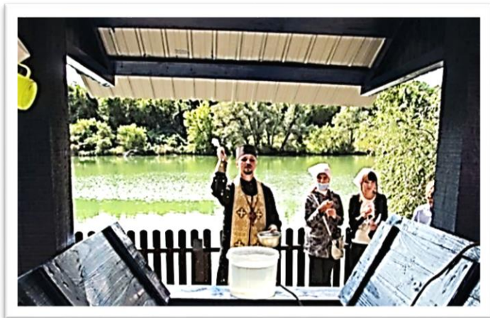
Рис. 4. Споруджений колодязь на місці криниці
