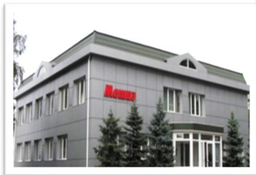
Рис. 3. Будівля заводу «Метиз» в м. Охтирка.
